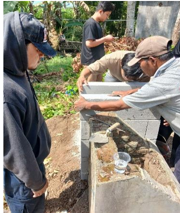
Gambar 2. Pembuatan Incinerator (tempat pembakaran sampah) Dusun Krajan
