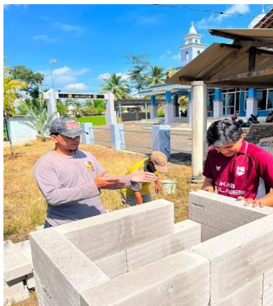
Gambar 1. Pembuatan Incinerator (tempat pembakaran sampah) Dusun Delima
