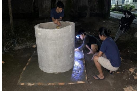
Gambar 3. Penyelesaian dan penguatan konstruksi menggunakan semen
