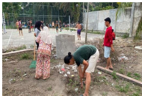
Gambar 1. Pembersihan lokasi pembangunan sarana pembakaran sederhana
