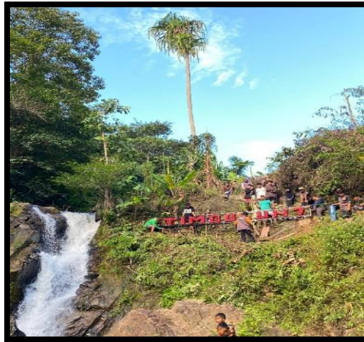
Gambar 1. Pemasangan Plang Nama Dari Ecobrick di Objek Wisata Air Terjun Timbulun 7
