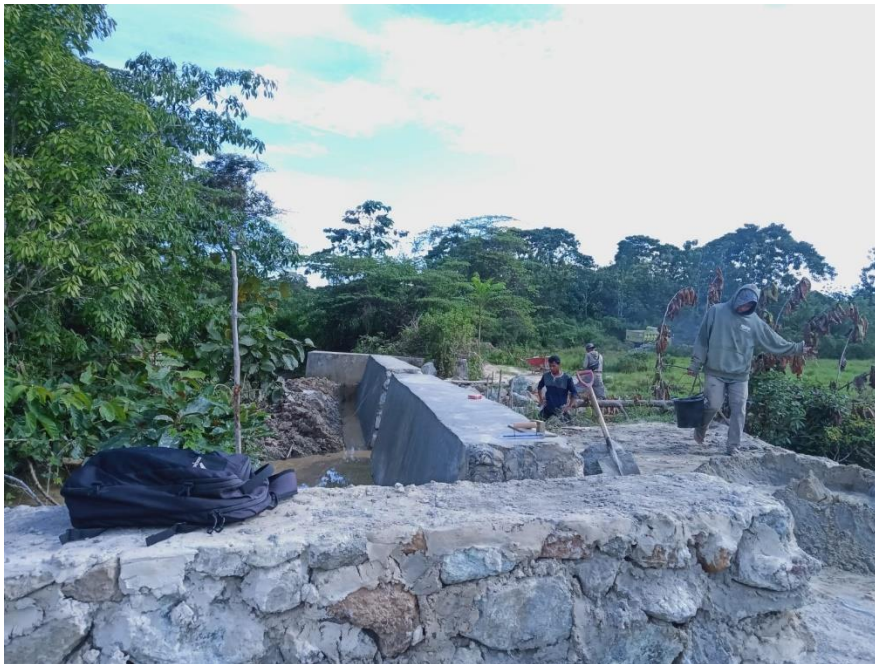
Gambar 5. Pekerjaan Konstruksi Bak Penampungan PAH di Desa Nario Indah
