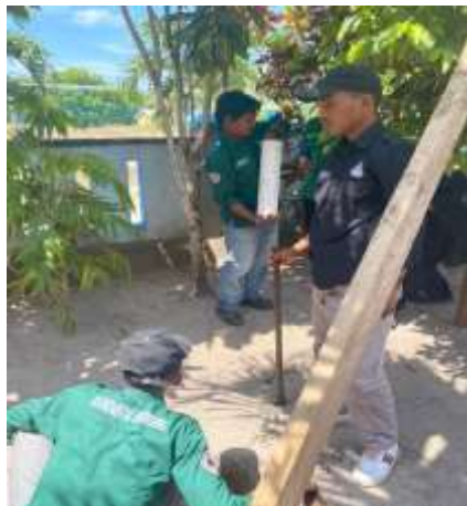
Gambar 5. Pemasangan Pipa PVC
